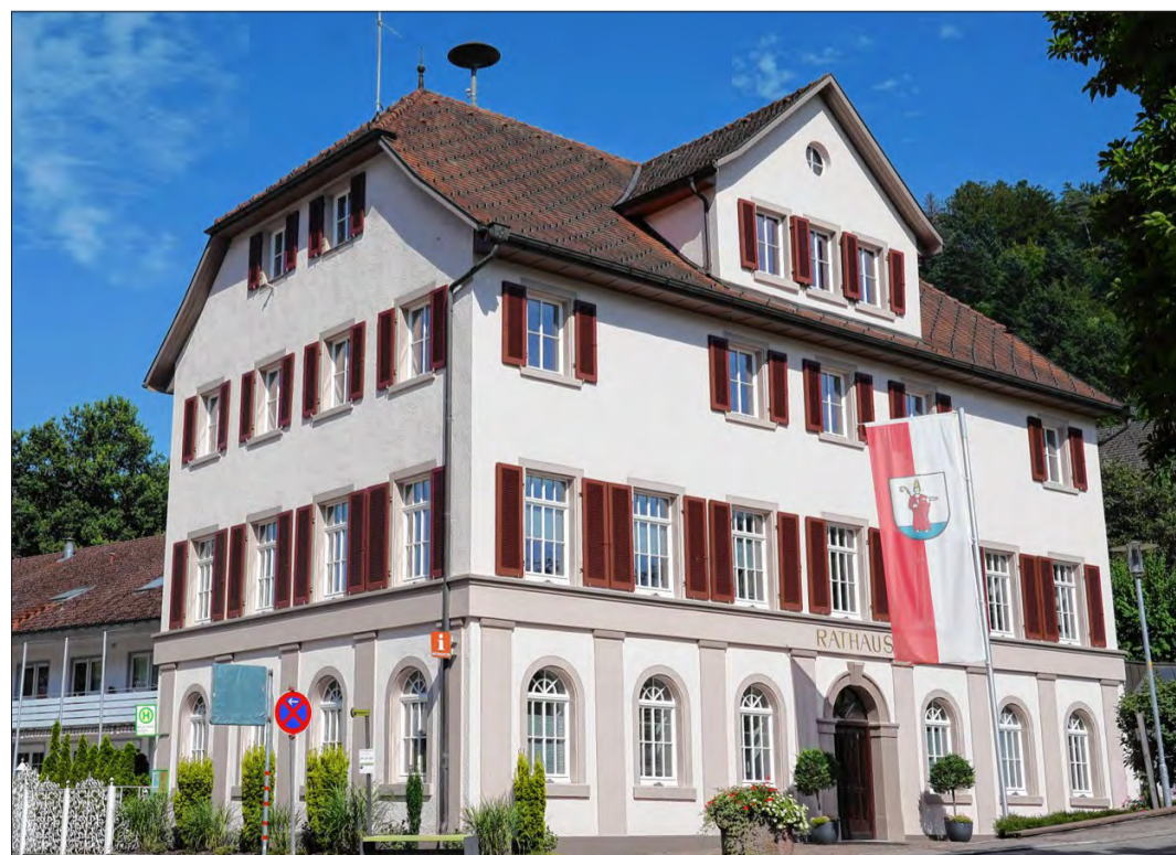
Das Nordrachter Rathaus ist generalsaniert und strahlt wie neu.
