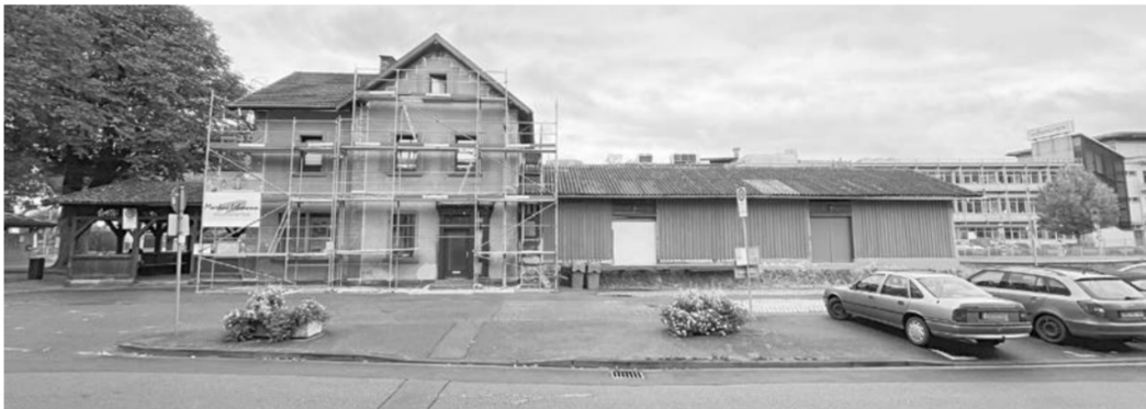
Am Zeller Bahnhof werden Sanierungsarbeiten durchgeführt. Das Hauptdach zeigt sich von seiner besten Seite: Es ist dicht und robust.
