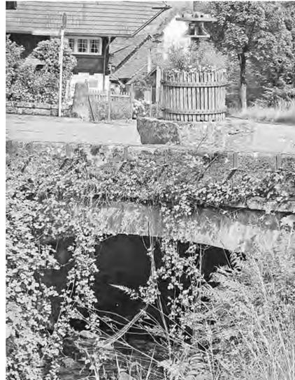
Der gemauerte Bogen der Brücke bei Schwarz-Webers sieht idyllisch aus, ist aber marode. Er wird abgebrochen und durch einen geraden Betonauflauf ersetzt. Die Sanierung ist für 2026 / 2027 geplant.
